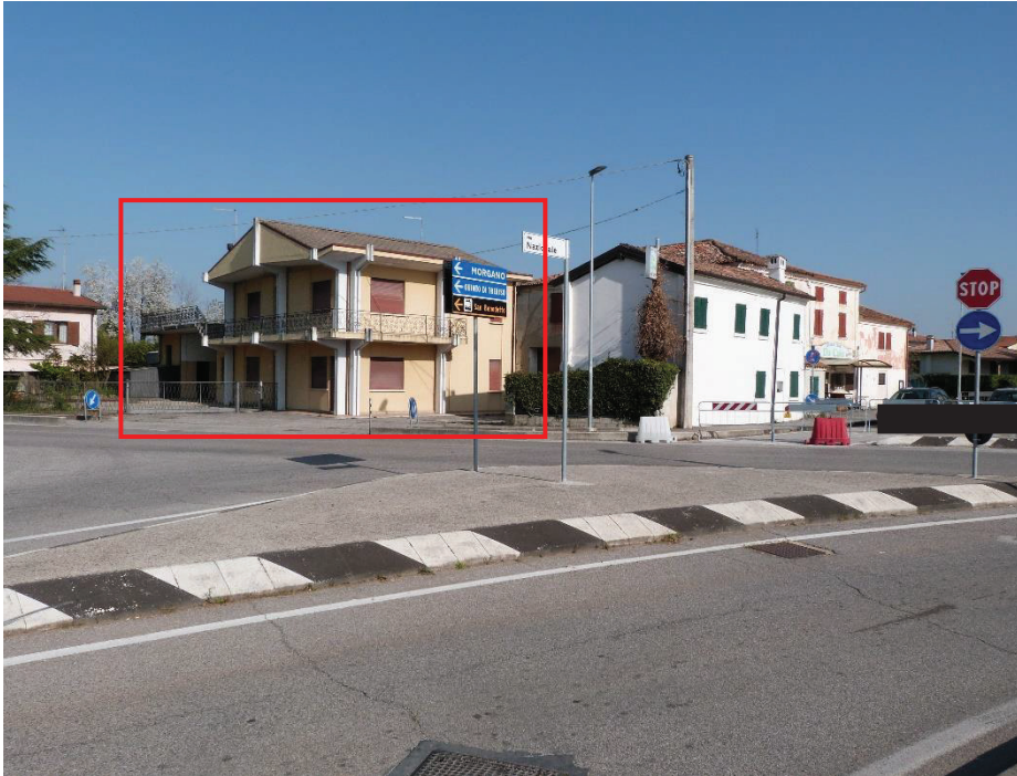
1 Vista dell'immobile posto all'incrocio tra via San Gottardo e la SR 53 Postumia.
